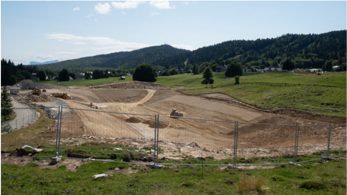
Les travaux en cours à La Féclaz, août 2021 © plbillot
